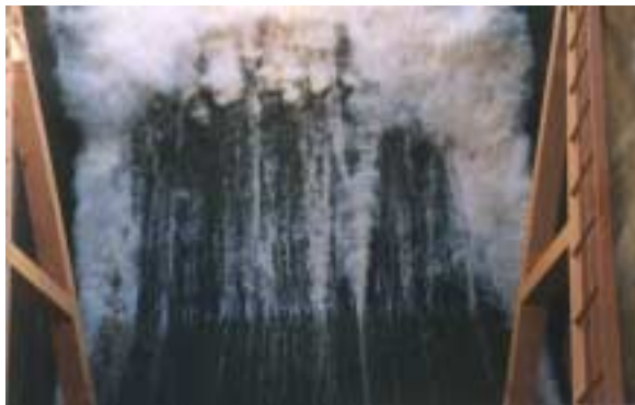
1 vertedero brazo Aña Cuá con los deflectores en funcionamiento
