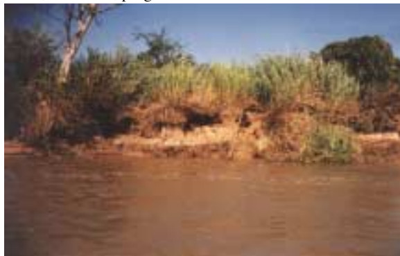
4b erosión de orillar en margen izquierda de isla Yacyretá, frente a isla San Rafael
