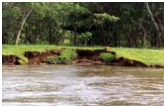
g erosión de orillares por bombeo hidrostático, margen derecha, ca. confluencia de arroyo Atinguy
