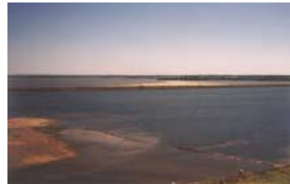
3 vista parcial de isla Yaguapy-reí desde presa de tierra progresión 19.800
