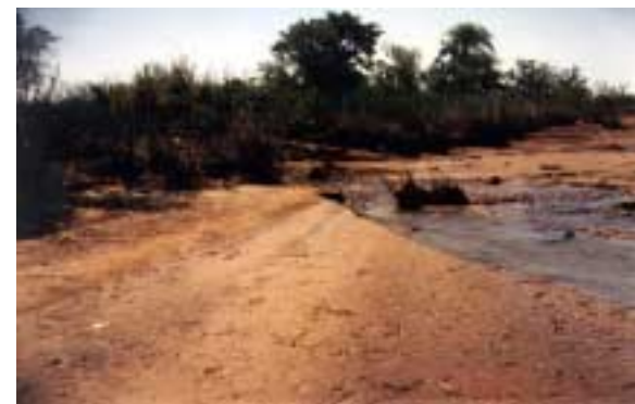
5c vista lateral de futuro canal de drenaje de a° Aguapey
