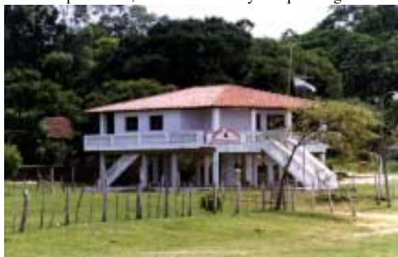
o Base Naval-Armada Paraguaya, en Ayolas, construida en dos niveles como protección contra las inundaciones
