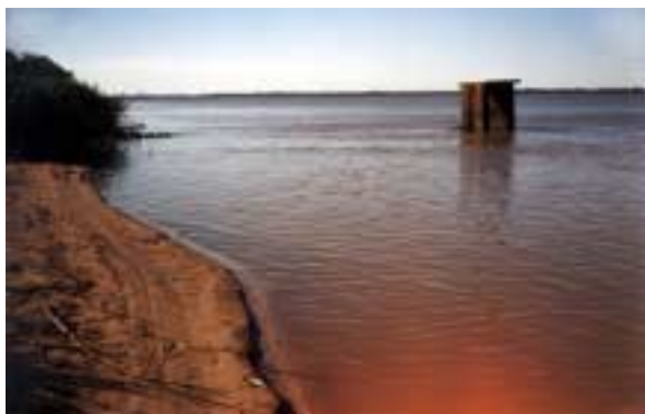
11a estructura para alojar captación y bombas de la toma de agua potable de Ayolas
