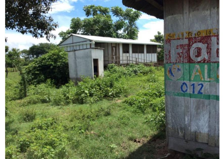
Huella de inundación en baño y muro de tablas
