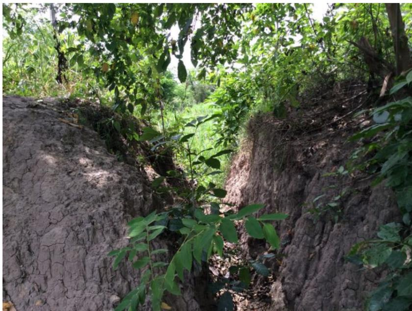
Boquete en jarillón posterior para drenar anegamiento
