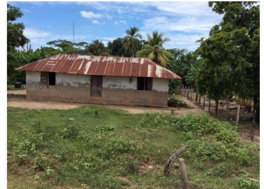
Huella de inundación en paredes, muro en puerta y socavación del pretil
