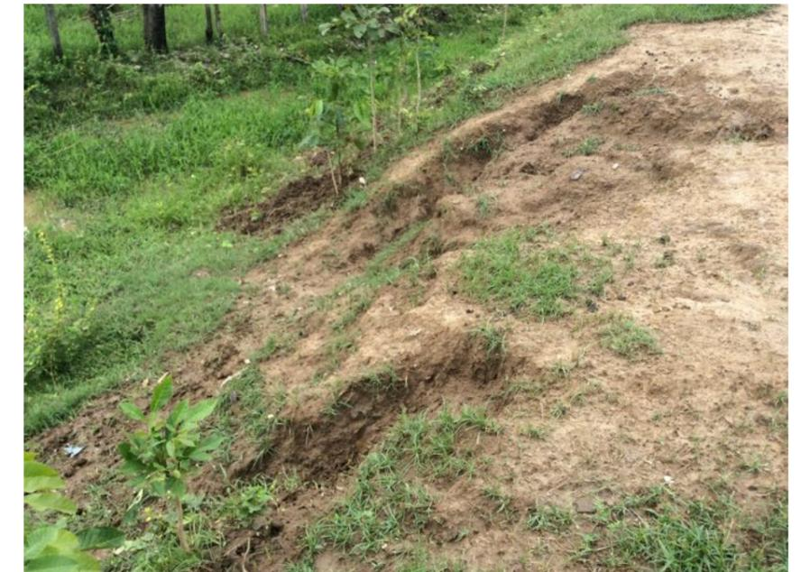
Excavaciones de cerdos, inicio de erosión en jarillón
