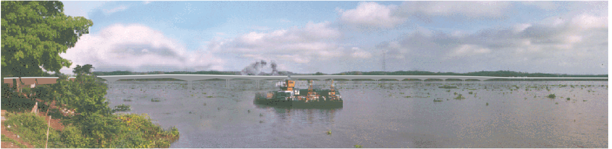
Panorámica del Puente desde Zambrano - Fotografía y perspectiva J.F. Angel. Montaje El Diseño
