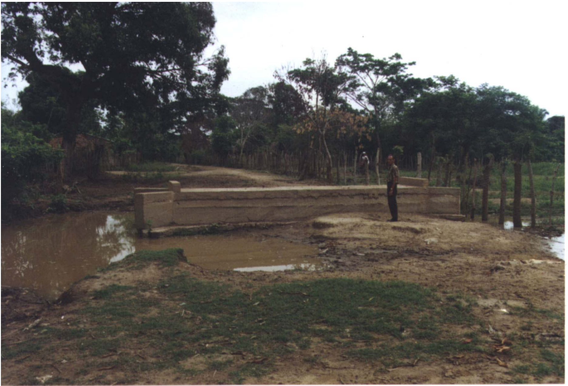
Deterioro de la vía por interferencia del drenaje e ineficientes estructuras, sector Guataca (Isla de Mompox).
